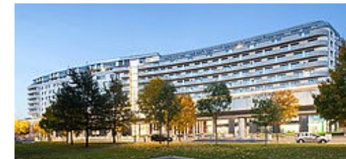
LINKED LIVING – Wien, Anzahl Einheiten: 589 Verwaltungsübernahme: 10.2015 Leistungen: Property Management, Vermietung, Concierge, Facility Management, Kommunikation
